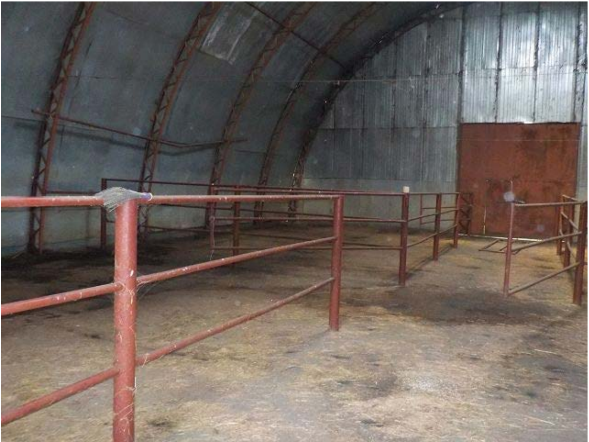
Bild 6: Innenansicht der Rundhalle – Station Gagarin
